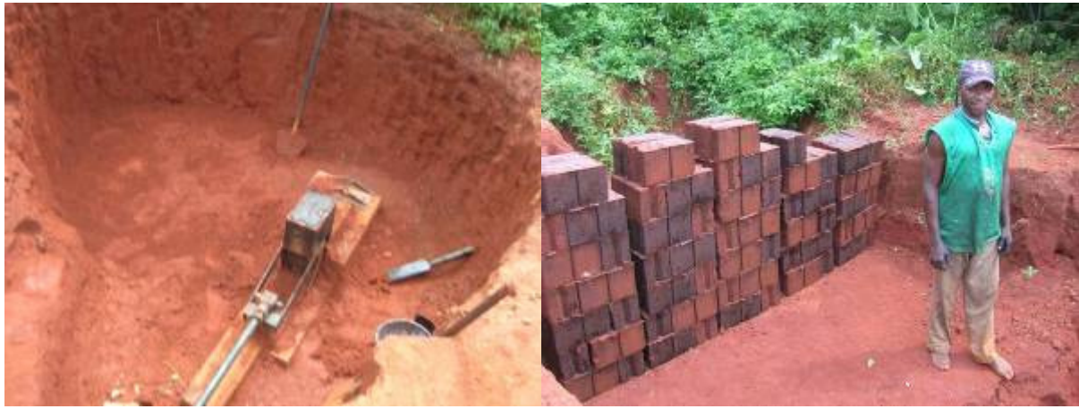
Figure 10 : Fabrication de parpaings en terre, village de Douwessué
