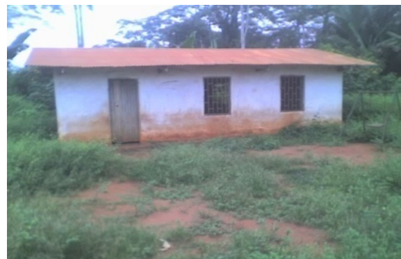
Bâtiment abritant le centre d'éducation de base
