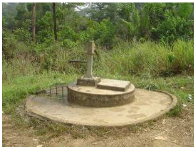
Figure 10. Forage aménagé à proximité de la gare ferroviaire riveraine de Ngongos .
