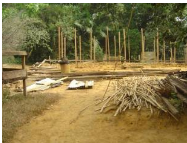
Figure 12. Chantier pour un construction en terre battue .
