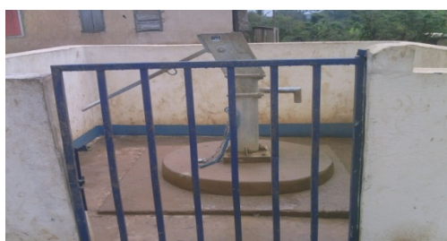
Photo n°7 : Point d'eau réalisé dans un village riverain
