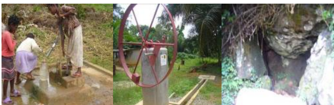
Photo 7: Les points d'approvisionnement en eau potable dans la ville d'Akom II, Efoulan et Mvie
