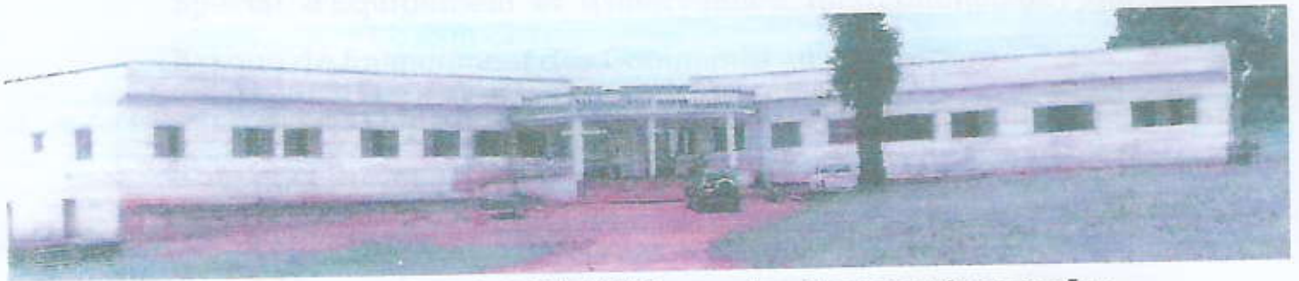
Hôtel de ville de DIMAKO construit en partie avec les revenus provenant de l'exploitation de la FCD
